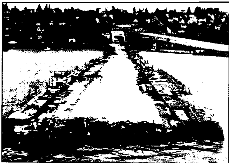
图8-1 西雅图90号州际浮桥的一部分在一场风暴中沉没了，原因是未遮盖浮箱，而在风暴中进水，使得桥体过重而无法继续漂浮。在建设时要防范一些小事情，它们的严重性往往会超过你的预期
